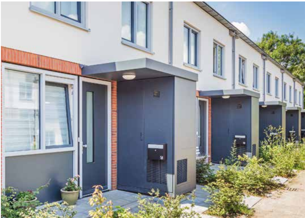
In Arnhem Presikhaaf heeft Portaal in het kader van de Stroomversnelling 96 woningen losgekoppeld van een gasaansluiting
