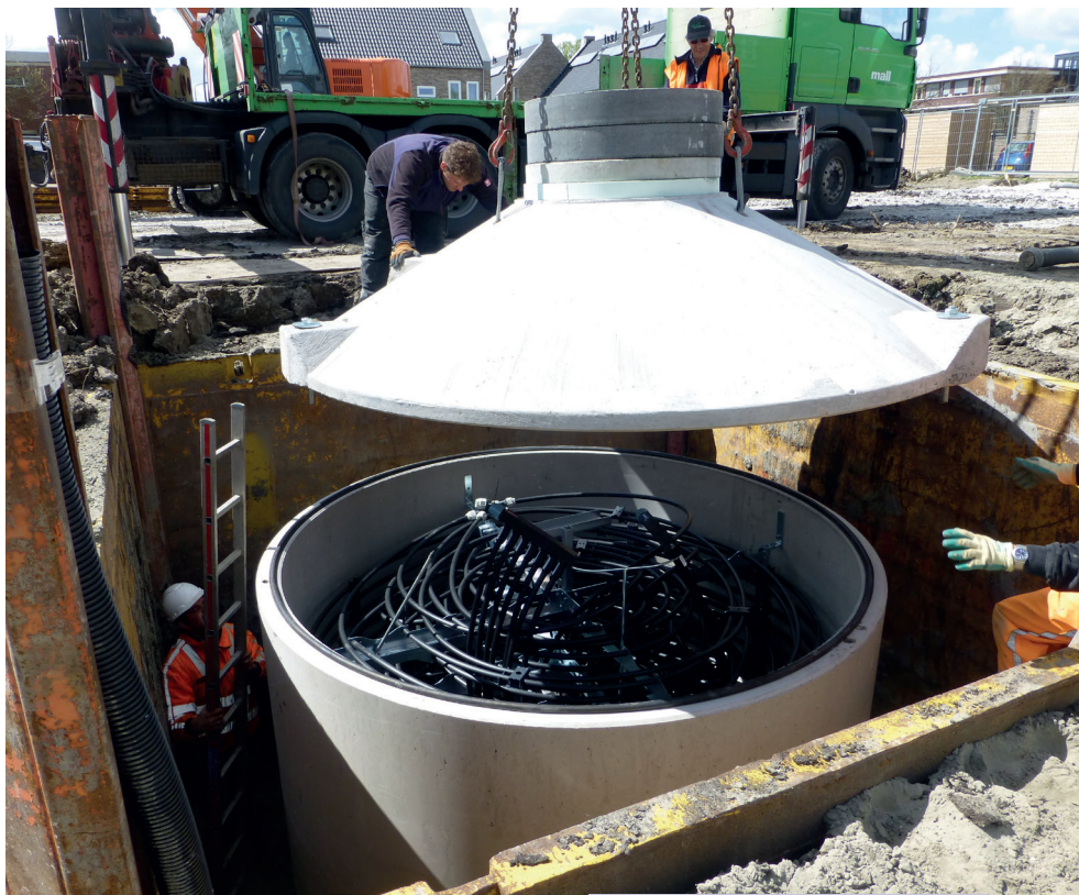
Plaatsing van eerste IJsbuffervaten in Goes-West
