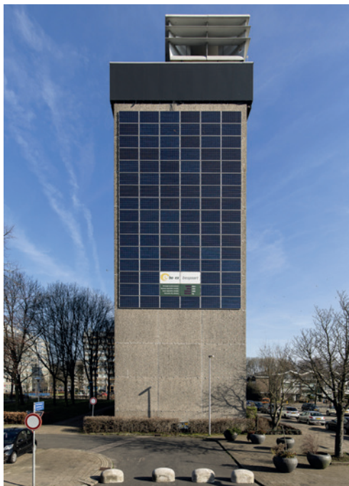
Flat ‘Henriëttedreef’ (Utrecht-Overvecht) met energievoorziening via dak, kopgevel en langshevel
